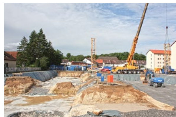
Die Bagger rollen in Wolfenbüttel und Braunschweig und haben u. a. bereits die Baugrube ausgehoben.
